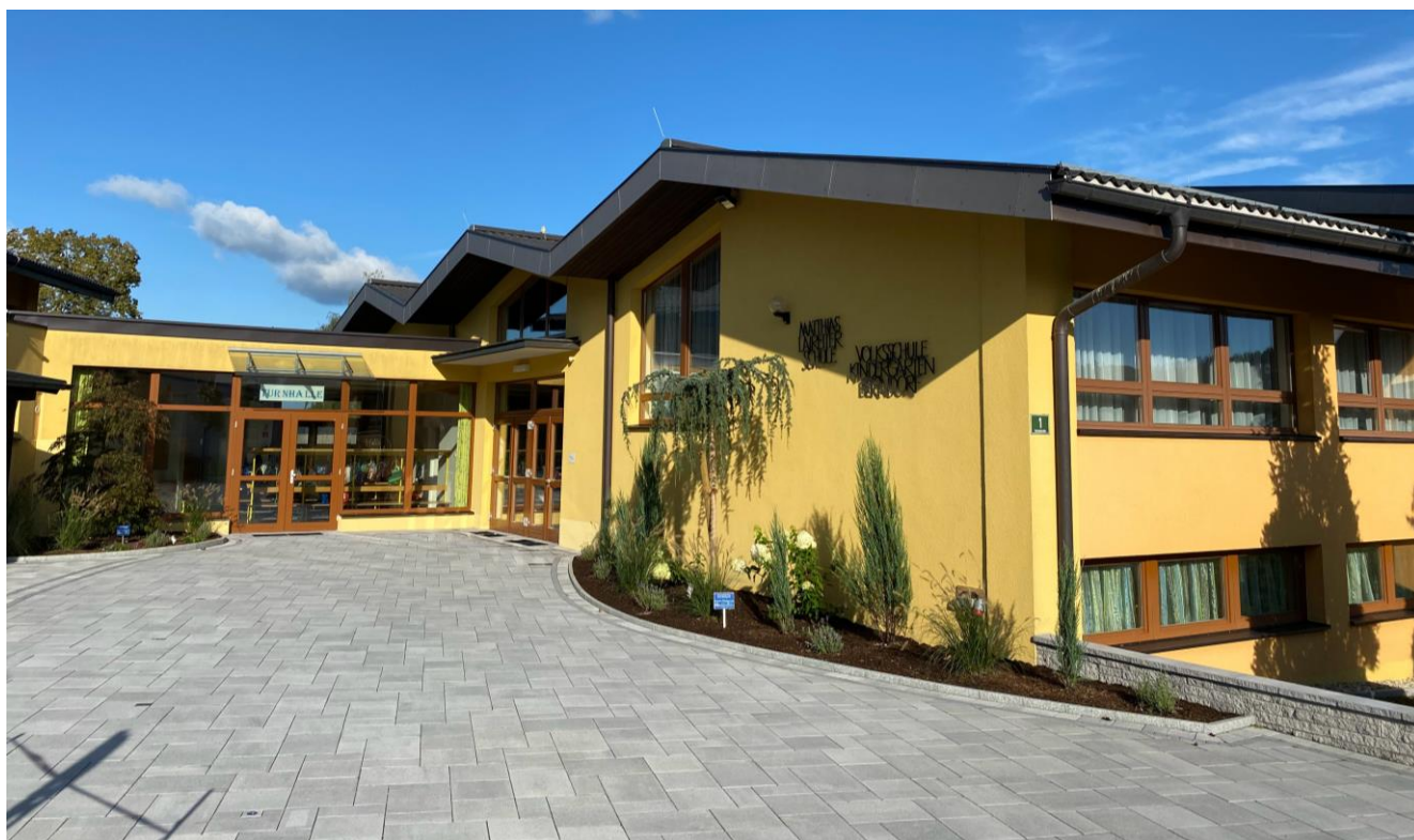
Neu gestalteter Eingangsbereich der Volksschule Berndorf
