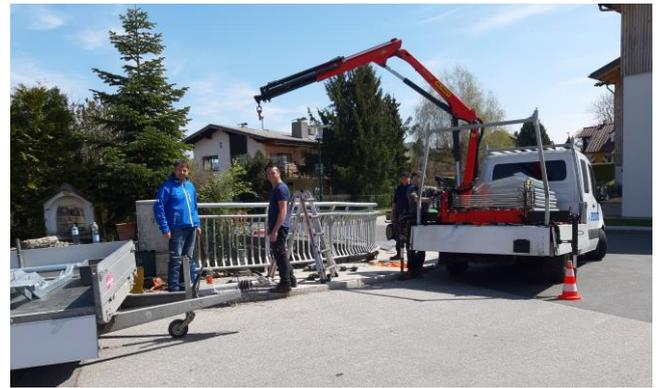
Von der Firma Pergo Gerätebau GmbH wurde ein Stahlgeländer in derselben Form wie auf der gegenüberliegenden Seite aufgebaut.
