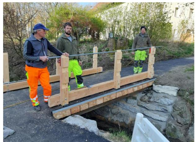
festgestellt. Aufgrund dessen wurde die alte Brücke vom Güterwegerhaltungsverband abgetragen und durch eine neue, auf Stahlträgern aufgebaute Brücke ersetzt.
