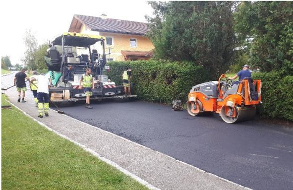
Die festgestellten **Schäden im Asphalt**, Bankette sowie den Oberflächenwasserkanälen werden umgehend ausgebessert und saniert. Im Zuge dieser Sanierungsmaßnahmen wurden auch die **Brückengeländer** der Brücken am Berndorferbach Reit – Schallmoos sowie in Mayrmühl erneuert.
