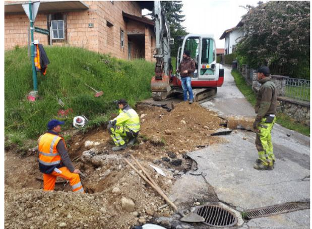
Im Bereich der **Kreuzung Siedlungsstraße/Lauterbachweg** mussten zwei defekte Kanalschächte für den **Oberflächenwasserkanal** erneuert und alte Betonrohre durch PVC-Rohre ersetzt werden. Mit den Asphaltierungsarbeiten wurden im selben Arbeitsgang die Gefälle zu den Einlaufschächten neu hergestellt.
