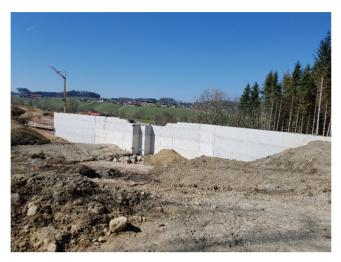
Als letztes soll dann die kleine Staumauer mit einem Rückhaltevolumen von rund 20.000 m³ im Wall-Holz errichtet werden. Damit soll das gesamte Projekt im Oktober dieses Jahres abgeschlossen sein.
