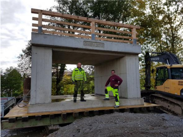
Ebenfalls aus Gründen der Sicherheit wurde die **Brücke über den Reiterbach** beim **Weiler Strauchmühle** neu gebaut und mit einem 90-Tonnen-Kran in das Gerinne eingesetzt.
