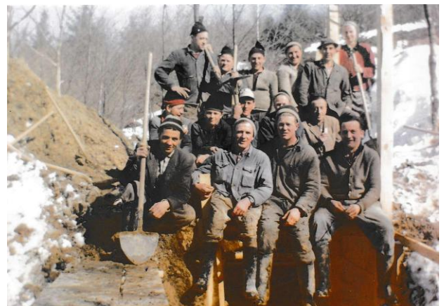
Händische Grabungsarbeiten 1963 Bild: Wassergenossenschaft Berndorf
