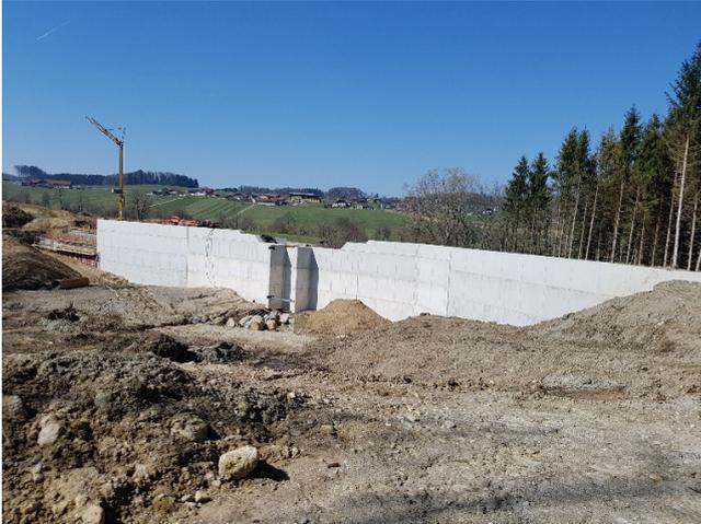
Als letztes soll dann die kleine Staumauer mit einem Rückhaltevolumen von rund 20.000 m<sup>3</sup> im Wall-Holz errichtet werden. Damit soll das gesamte Projekt im Oktober dieses Jahres abgeschlossen sein.
